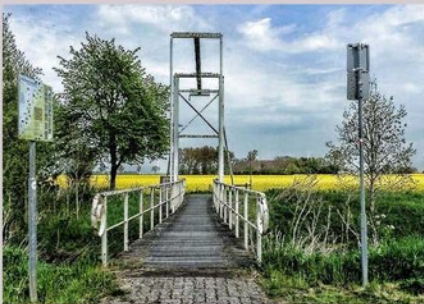
Noaberbrug Bad Nieuweschans
